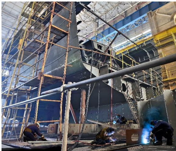
大型構造物の現場
