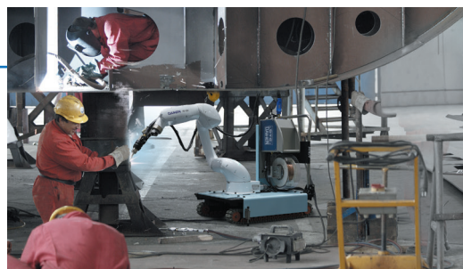
溶接作業現場イメージ
